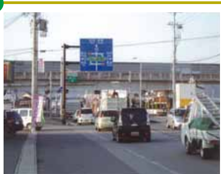
4 バイパスの出入口になっており、交通量が多い。通学路にもなっており、十分な注意が必要。
