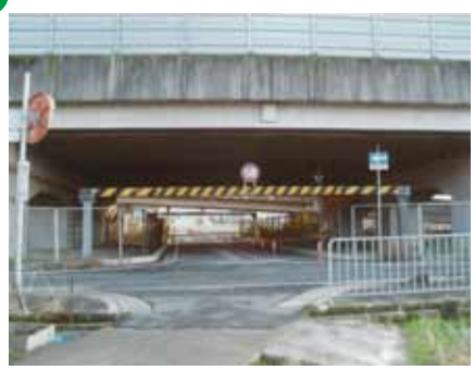
5 バイパスの下になっており、見通しが悪い。通学路にもなっている。PTAの巡回パトロール場所。
